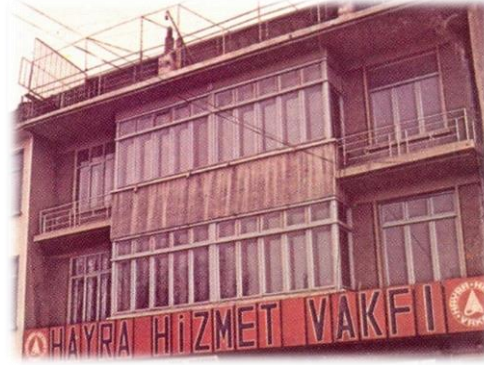
Allah Razı Olsun. Çalışkan ailesi tarafından vakfımıza bağışlanan ve bizim neşvü nema bulmamıza sebep olan, ilk taşınmazımız bu binadır. 15 sene kadar içerisinde oturup çalıştık. Halen kira geliri devam etmektedir.
